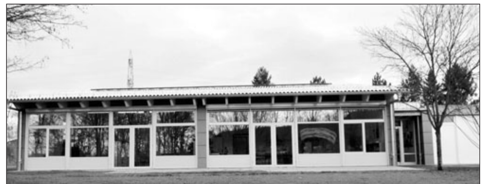
Auf dem Dach des Lindenschul-Hortes wurde die neue Anlage jüngst kaum sichtbar installiert.
